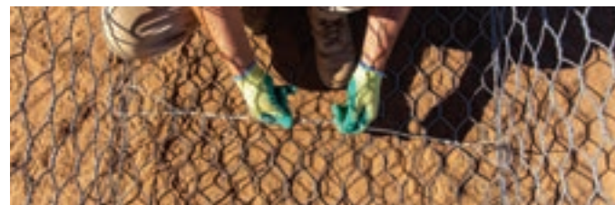
Fig. 4 - Lacing wire (top), pre-formed brace MacTie (bottom)
